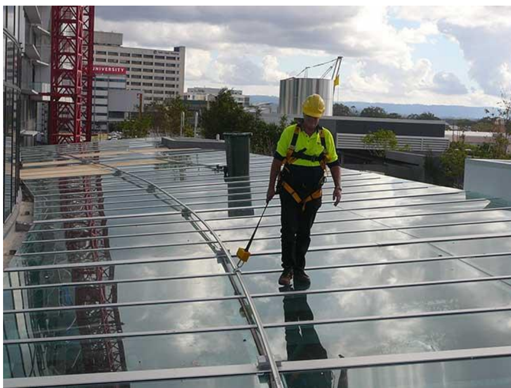
Figura 24. Exemplo de Sistema baseado em linha de ancoragem horizontal rígida. Fonte: CAI Safety Systems
