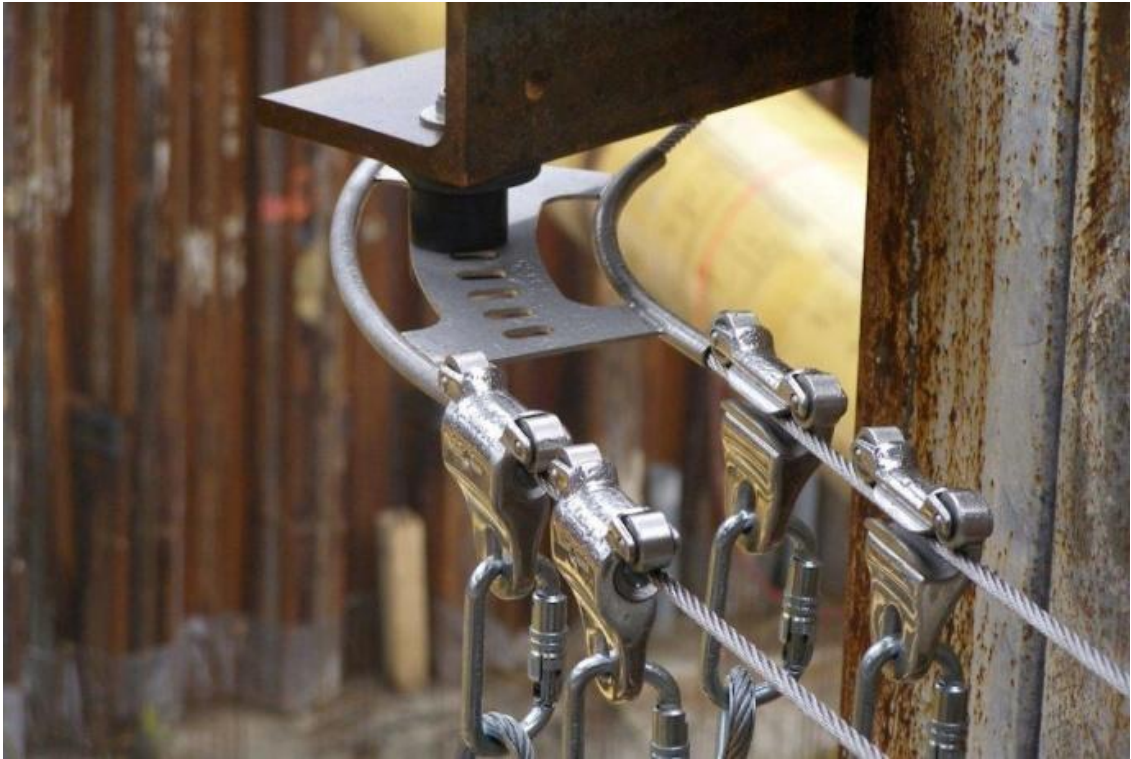
Figura 25. Exemplo de linha de vida horizontal dupla, que permite que um trabalhador passe por outro sem necessidade de se desconectar
