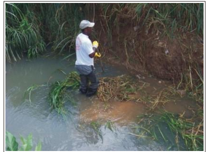
Limpeza manual de córrego
